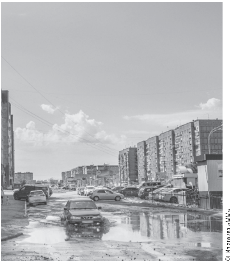
Неогороженный провал после зимних «раскопок» коммунальщиков глубиной больше полуметра перед домом № 29/1 по улице Галиуллина
