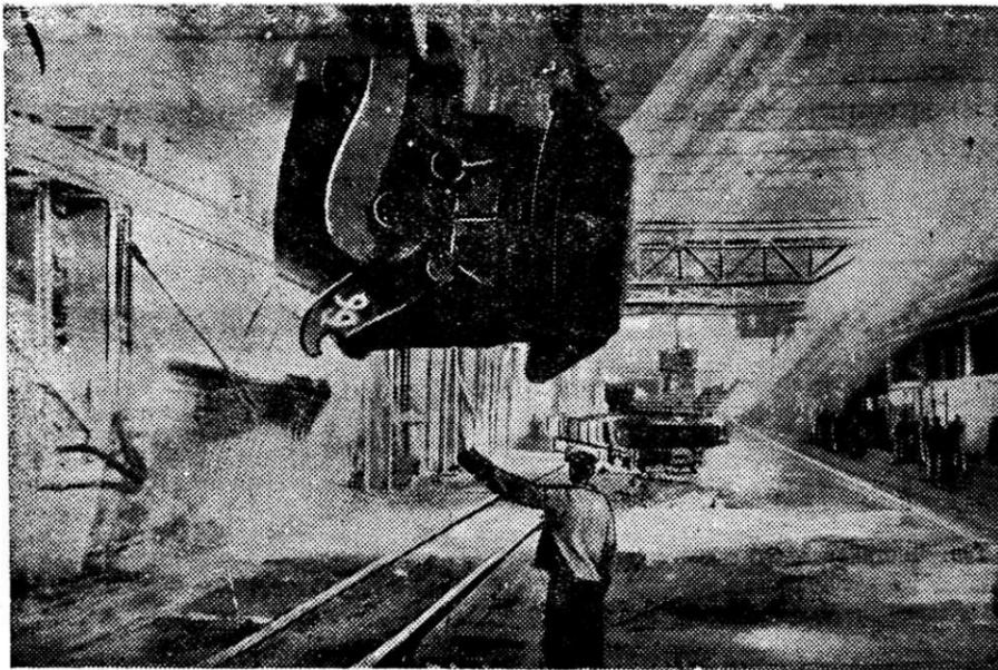
На снимке: печной пролет третьего сталеплавильного цеха нашего комбината. Идет заливка чугуна в мартеновскую печь.
