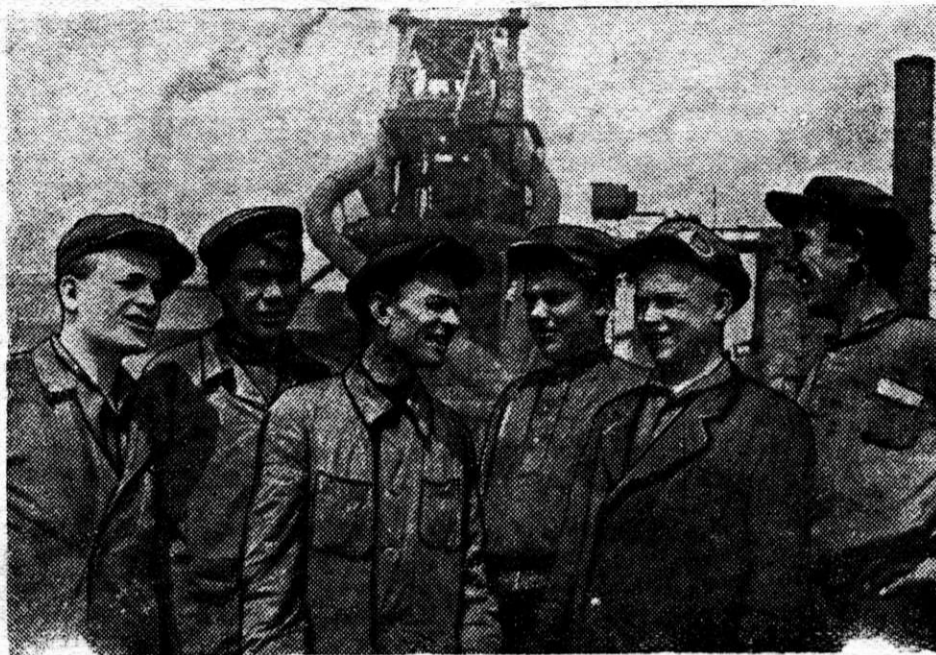
На ремонте второй доменной печи образцово работает бригада монтажников котельно-ремонтного цеха, которой руководит В. Бутусов.
