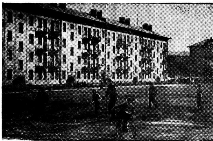
Это — 59-й квартал, который уже десяток лет не благоустроен. Детям приходится играть и кататься на велосипедах или просто играть на площадке, изрытой и усыпанной обломками кирпича и битым стеклом.
