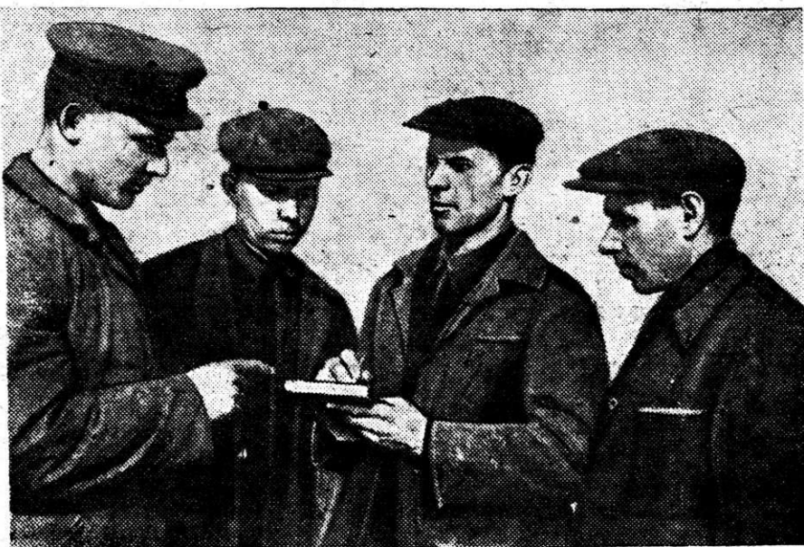
По-стахановски выполняют взятые обязательства на ремонте первой доменной печи монтажники котельно-ремонтного цеха бригады т. Стаценко. На снимке (слева направо): монтажники В. А. Аржаев, И. П. Якушин, И. А. Стаценко (бригадир) и С. И. Колбаса знакомятся с заданием перед заступлением на смену. Фото П. Рудакова.
