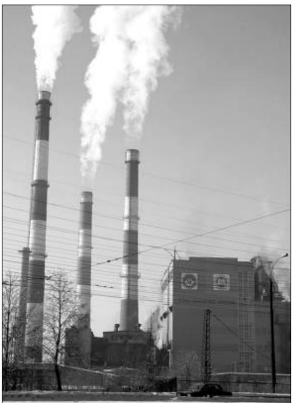
В ОБЩЕМ ОБЪЕМЕ вырабатываемых комбинатом собственных энергоресурсов доля теплоэлектроцентрали по электроэнергии составляет более половины, а по теплу – шестьдесят процентов. ТЭЦ обеспечивает теплом Орджоникидзевский и Правобережный районы города и часть промышленной площади ММК, снабжает паром, технической и химически очищенной водой четвертую кислородную станцию.
