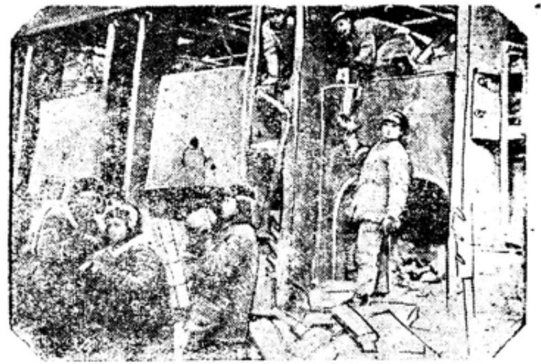
В мартеновском цехе. Ремонт восьмой печи.
