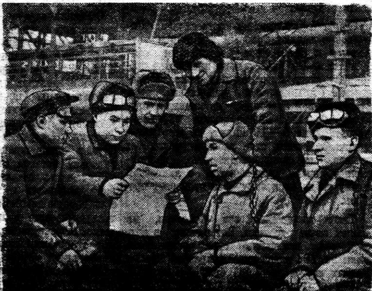
Передовая бригада плотников ремонтно-строительного цеха П. П. Дубинина во время ремонта домны систематически выполняла по две нормы, и 4 апреля выполнила задание на 304 проц. На снимке: бригада Дубинина в обеденный перерыв за чтением газеты. Читку проводит десятник т. Травин. Фото П. Рудакова.
