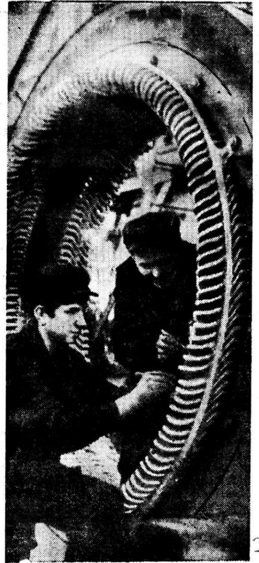
Трудящиеся кустового электроремонтного цеха прокатного и мартеновского производств ведут ремонт электрооборудования.
