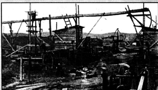
Котлован первой плотины.
