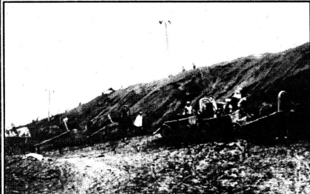
Строительство второй плотины.
