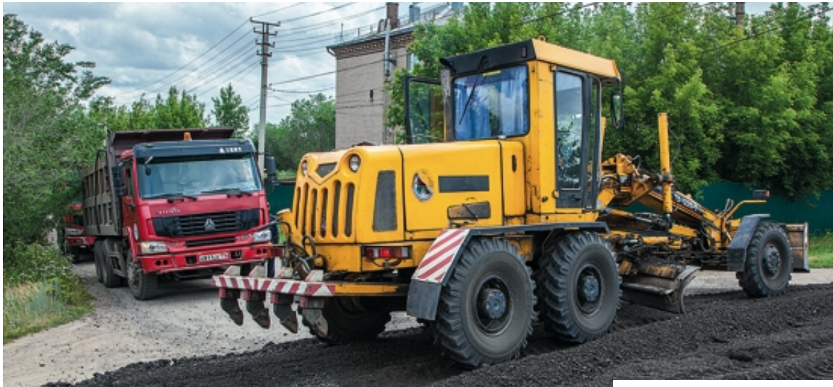
Отсыпка дороги на улице Красина посёлка Карадырский
