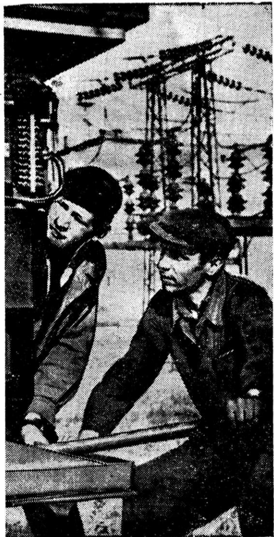
Ремонт электроаппаратуры распределительных устройств подстанций — сложное и ответственное дело. От качественного ремонта аппаратуры во многом зависит безаварийная работа электроустройств.
