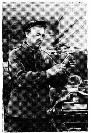
На снимке: передовой бригадир слесарей копрового цеха М. В. Кузин, обеспечивающий бесперебойную работу кранов.
