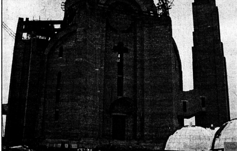
Июль 2000 года. На строительстве нового храма.
