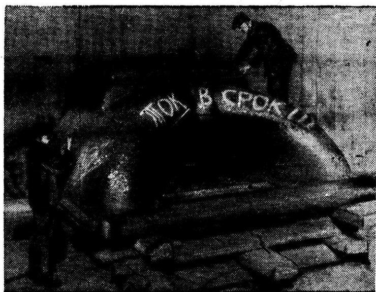
МОНТАЖ ПЕРВОГО АГРЕГАТА ЦЭС.
