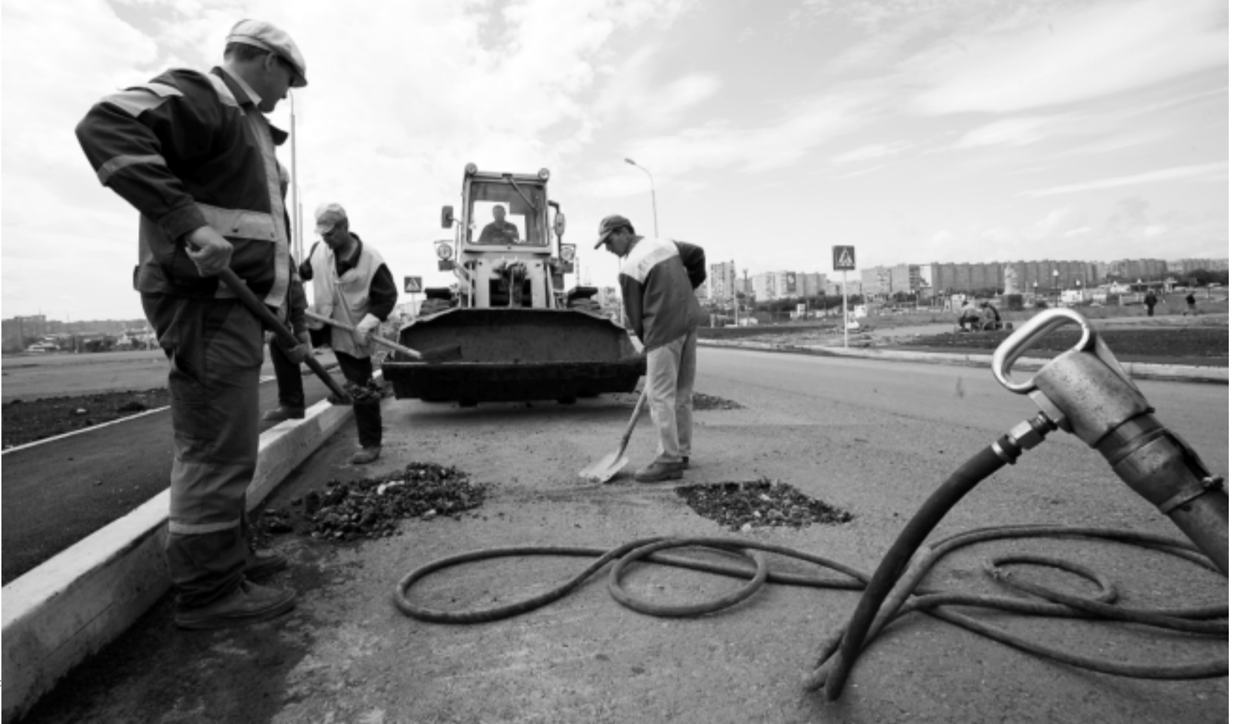
До Дня металлурга новая трасса состыкуется с улицей Сталеваров
