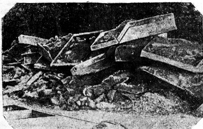
Шлак свалка на рабочей площадке мартеновского цеха, против печи № 10. Фото Н. Винова.
