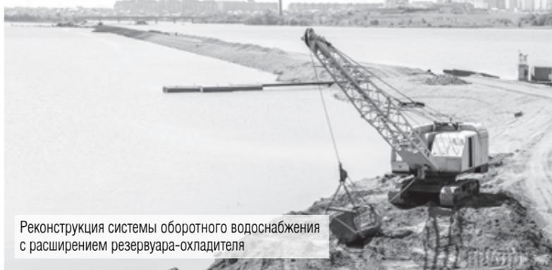
Реконструкция системы оборотного водоснабжения с расширением резервуара-охладителя
