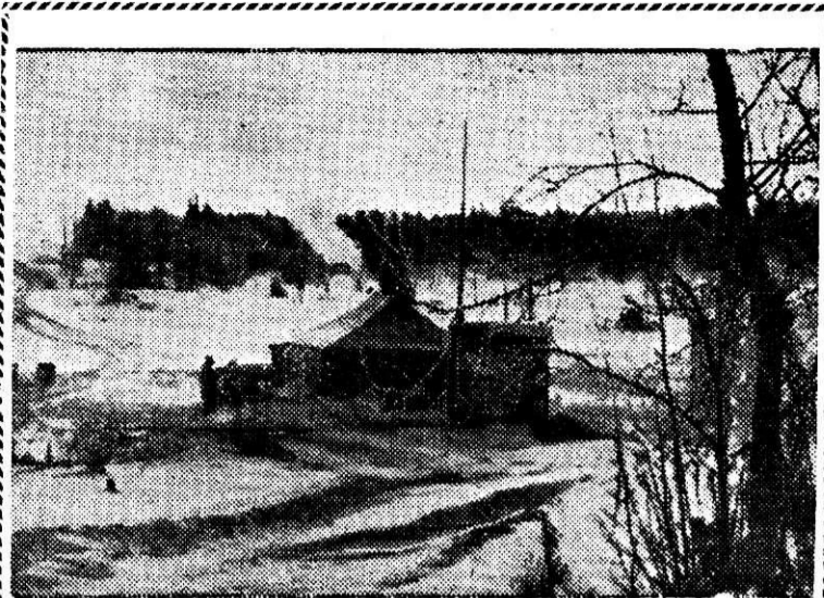
На снимке: у этой палатки база лэповцев. Здесь они живут, ремонтируют технику, здесь ежедневно принимают вертолеты.
