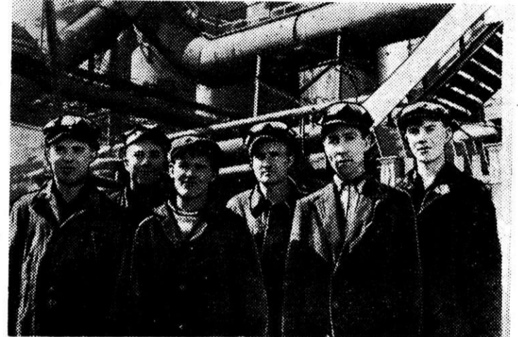
На ремонте первой доменной печи высоких показателей достигла бригада монтажников «Уралдормремонт» Дябилина. Она изо дня в день выполняет норму на 180—200 проц. На снимке: бригада монтажников П. Дябилин, А. Павлов, В. Галайда, Н. Макаров, Ш. Муратшин, П. Свиштунов. Фото Е. Карпова.
