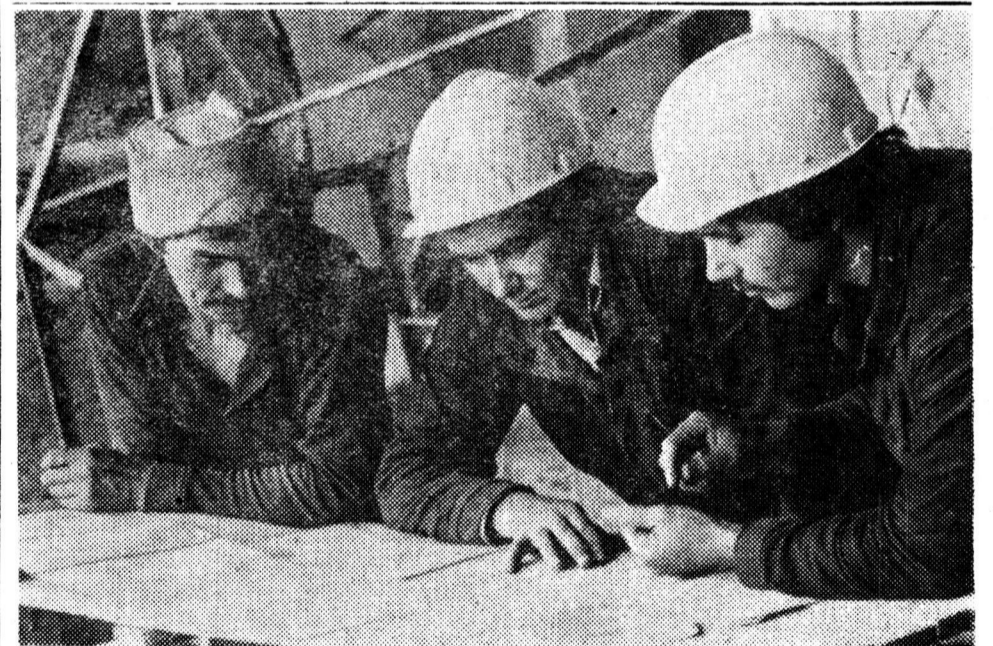
В коллективе, ведущем сооружение цеха углеродистой ленты, немало славных подразделений. Среди них известна и бригада электромонтажников Юрия Кузнецова. Этот небольшой коллектив выполняет большие работы на насосной станции № 81. Нормы выработки бригада Кузнецова выполняет на 125—130 процентов.
