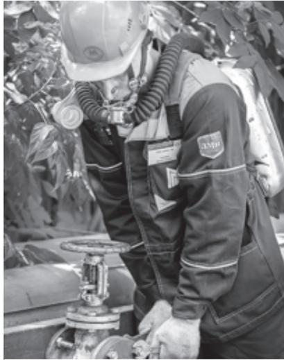
Установка заглушки на повреждённом участке газопровода
