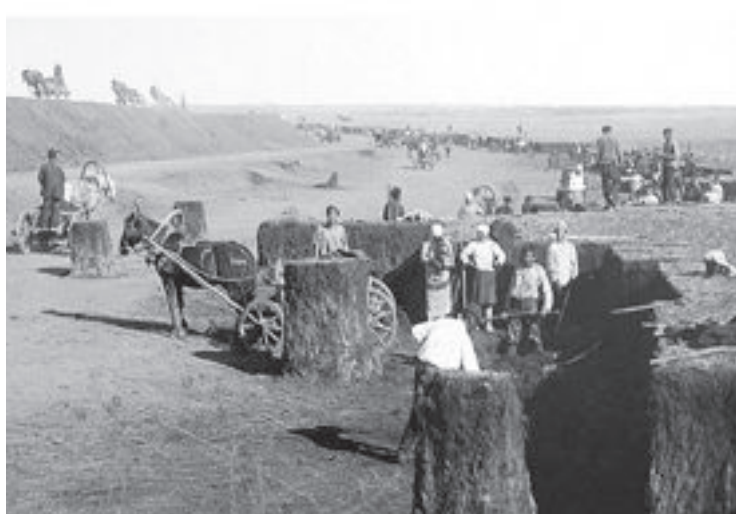
Строительство железной дороги, 30-е годы
