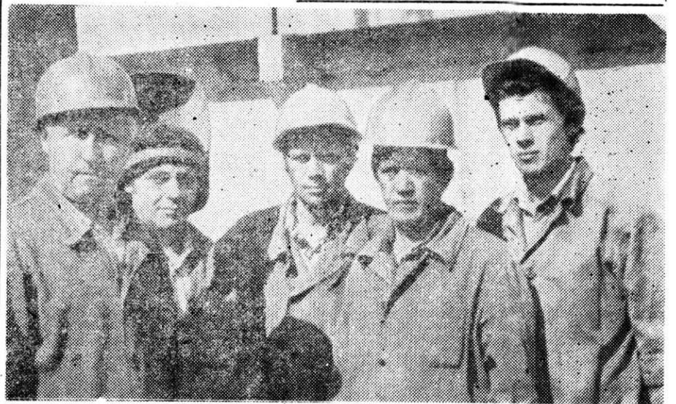
Коллектив строительного-монтажного управления комбината ведет большие работы по реконструкции и строительству новых объектов, необходимых для расширения производственных площадей и увеличения выпуска продукции.
