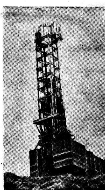
ЕЖЕГОДНО ТРУД ГОРНЯКОВ ОБЛЕГЧАЕТСЯ НОВОЙ ТЕХНИКОЙ. НЕ ТАК ДАВНО НА РУДНИКЕ ВСТУПИЛИ В ЭКСПЛУАТАЦИЮ НОВЫЕ ШАРОШЕЧНЫЕ БУРОВЫЕ СТАНКИ, ИХ ПРОИЗВОДИТЕЛЬНОСТЬ В 6-7 РАЗ ВЫШЕ СТАНКОВ КАНАТО-УДАРНОГО БУРЕНИЯ. ЗА СМЕНУ НОВЫЙ АГРЕГАТ ПРОБУРИВАЕТ 70-80 ПОГОННЫХ МЕТРОВ СКВАЖИН. СОВЕРШЕННАЯ ТЕХНИКА УСПЕШНО ОСВАИВАЕТСЯ ГОРНЯКАМИ. МАШИНА ОЧЕНЬ УДОБНАЯ В УПРАВЛЕНИИ, НА НЕЙ ПРИМЕНЕНА АВТОМАТИКА, ДИСТАНЦИОННАЯ СИСТЕМА.
