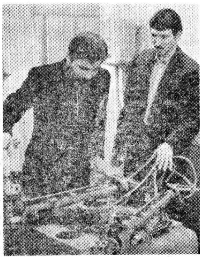
◆ На ремонте домны № 9
