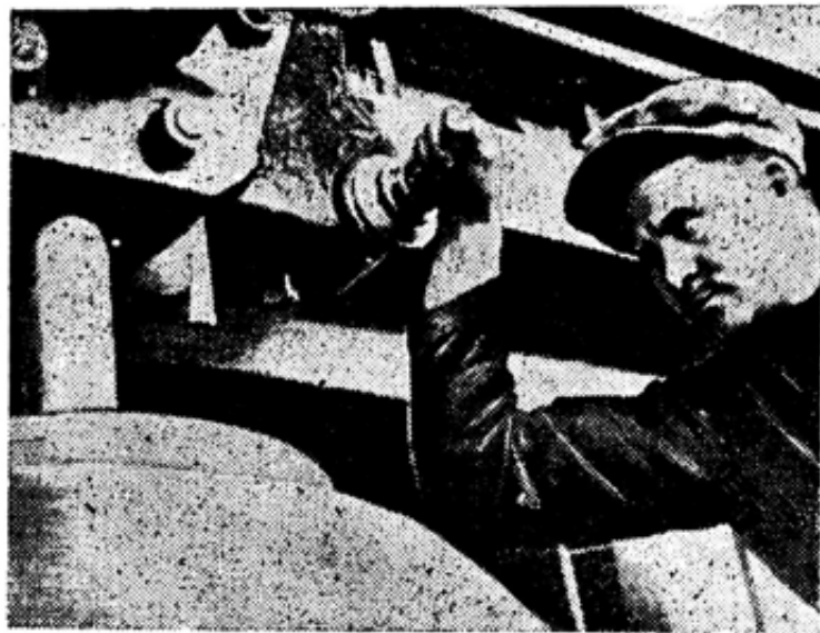
Лучшие стахановцы механического цеха выполняют заказы для ремонта доменной печи № 4. На фото т. Якубович—токарь обрабатывает малый конус. Фото В. Георгиева.
