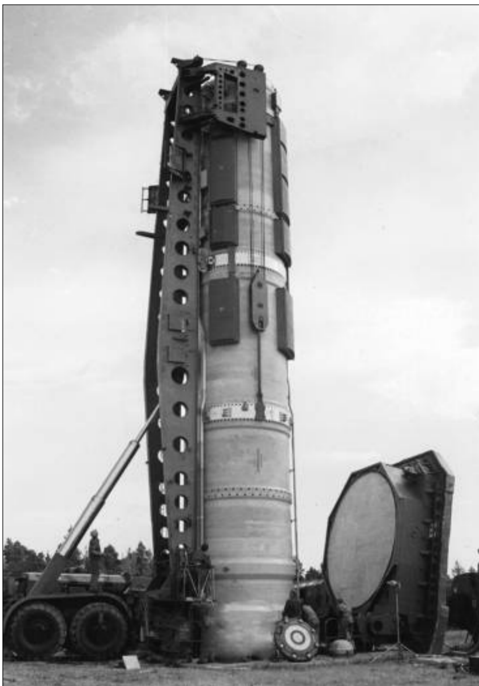
Загрузка ракеты SS-18 в шахту пускового управления ШПУ
