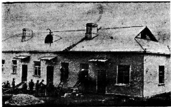
На снимке: четырехквартирный дом, построенный силами обжимщиков. В нем производятся отделочные работы перед сдачей в эксплуатацию.
