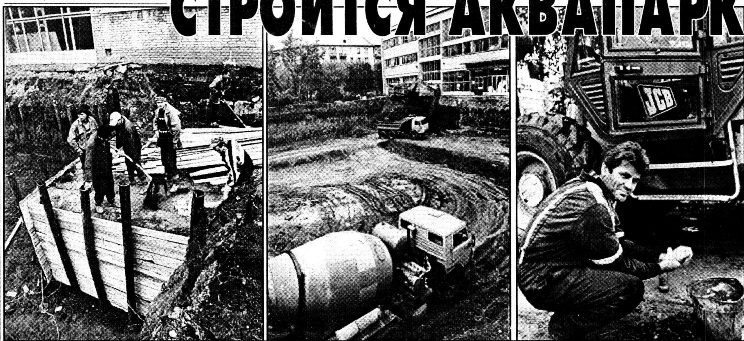
Работы на объекте в самом разгаре...
