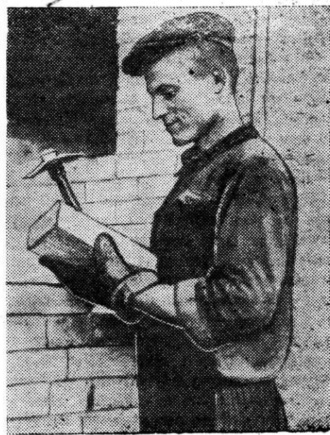
На снимке: один из лучших стахановцев каменщиков цеха ремонта промышленных печей П. А. Марьенков, систематически выполняющий по полторы-две нормы.
