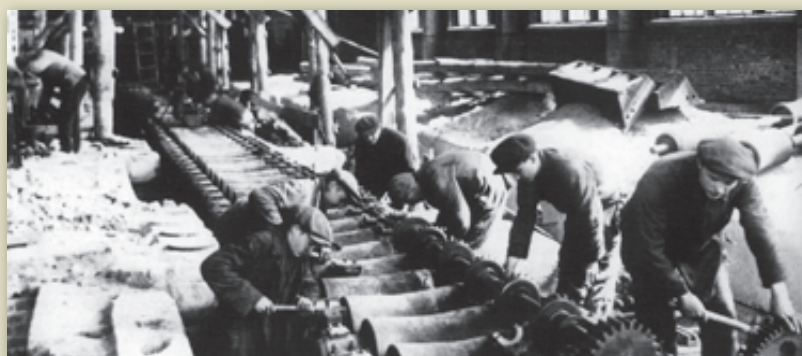
Магнитогорск. Монтаж оборудования эвакуированных предприятий. 1941–1942 гг.
