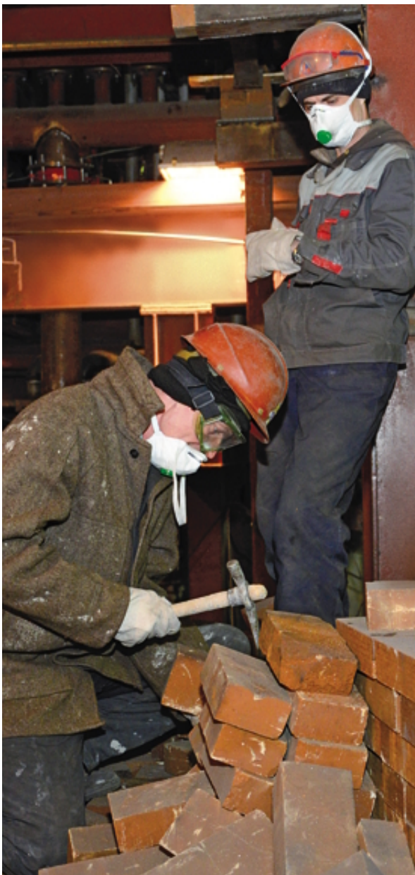
Капремонт двухвального сталеплавильного агрегата № 32 в ЭСПЦ
