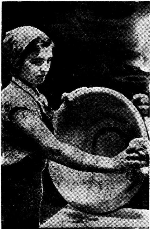
Много хороших работниц трудится в цехе металлической посуды. Роза Потопова — одна из тех, кем гордится цех. Работая эмалировщицей, Р. Потопова обеспечивает выходящую продукцию только отличного качества. На снимке: эмалировщица Роза Потопова за работой.
