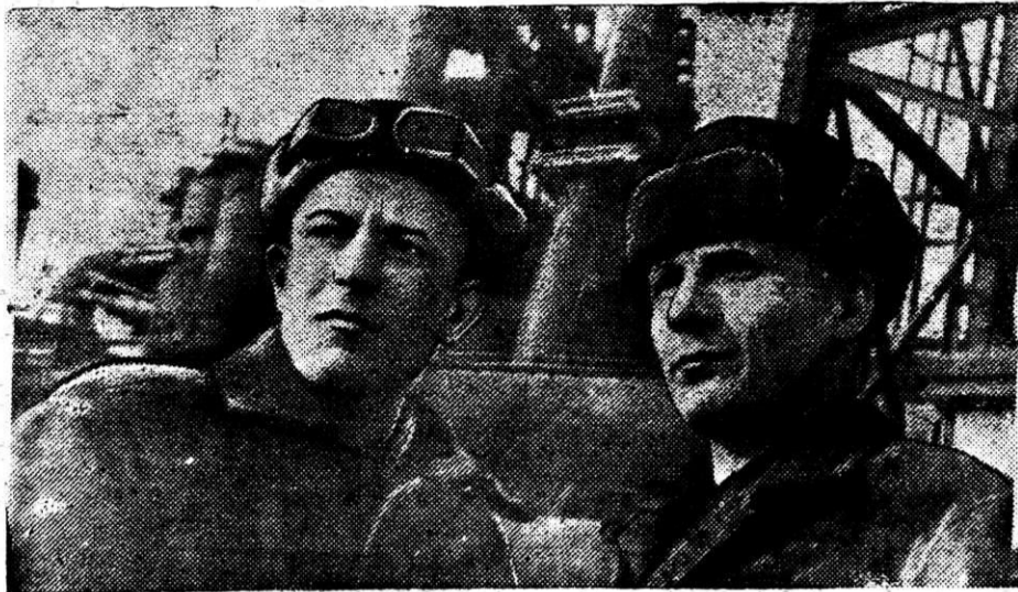
На ремонте 6-й доменной печи передовые котельщики показывают замечательные образцы работы, опережая установленный график. На снимке: монтажники котельно-ремонтного цеха А. Славягин и М. Давылов, выполняющие нормы выработки на 180 процентов.
