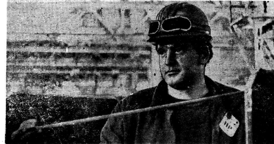
Готовимся к ремонту домны № 7. Фоторепортаж
