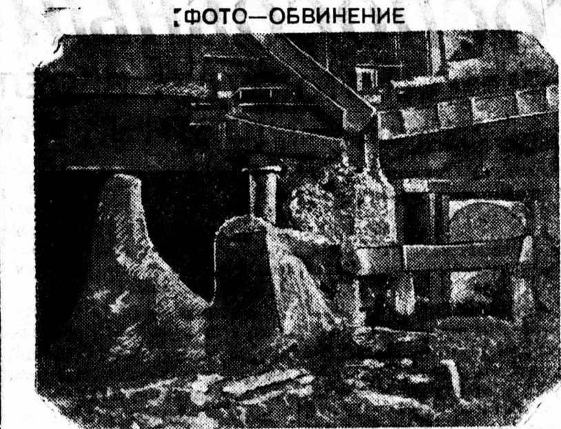
Борьба за чистоту рабочего места в мартенском цехе еще не развита. Посмотрите, в каком состоянии находится печь № 10. Посадки от шлаковых чаш залиты шлаком. Фото Новикова.
