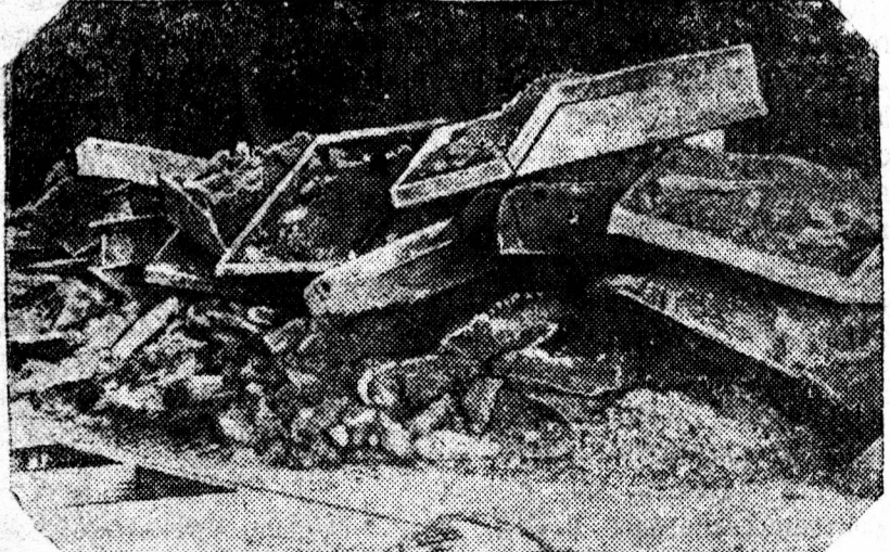
Шлак свалка на рабочей площадке мартеновского цеха, против печи № 10. Фото Н. Винова.
