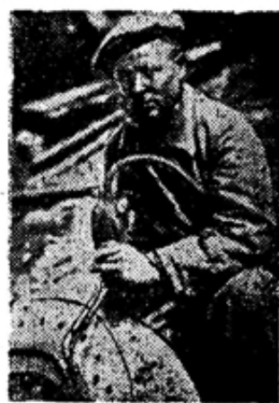
Автогенщик т. Парфентьев С. А., работающий на ремонте домны № 4, выполняет нормы свыше 150 проц.
