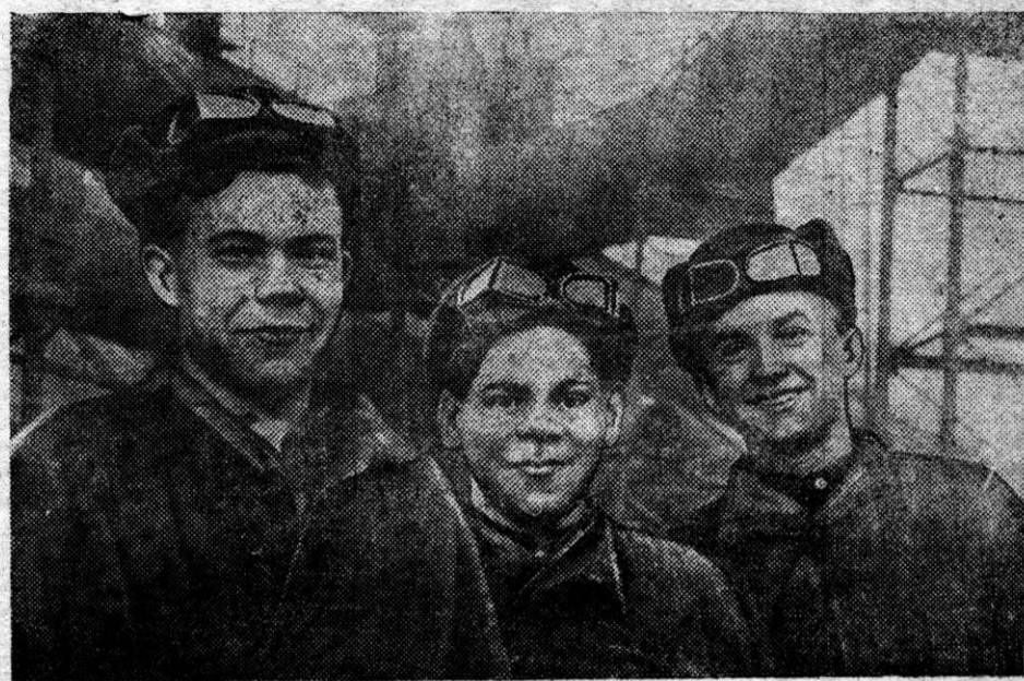
Комсомольско-молодежная бригада монтажников котельно-ремонтного цеха Старковского образцово работает на ремонте шестой доменной печи. На чеканке холодильника она систематически выполняет нормы свыше 170 процентов.
