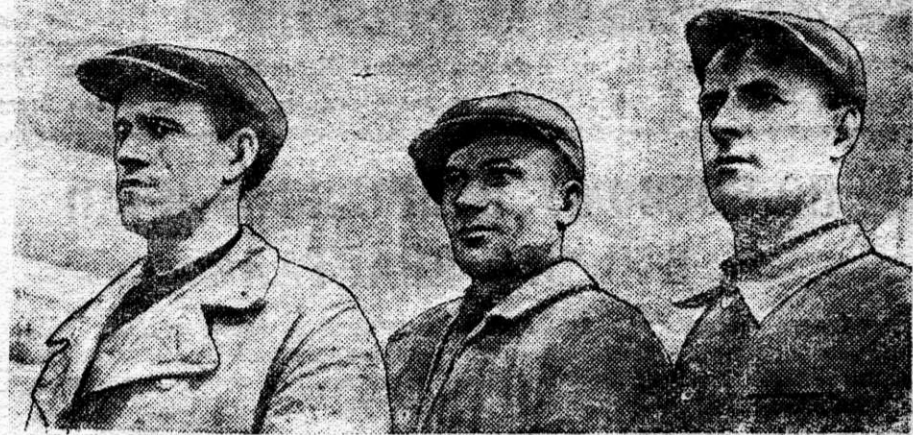
На ремонте пятой доменной печи образцово работают автогенщик котельно-ремонтного цеха А. Е. Доронин и бригады монтажников Н. В. Фокина и Б. А. Анпилогова. Они систематически выполняют свыше двух норм.
