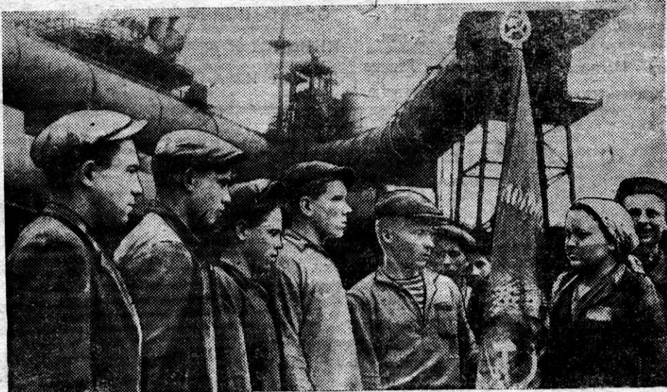
На ремонте пятой доменной печи, образцы труда показала бригада каменщиков стройуправления «Уралдомремонт», которой руководит А. Л. Злобин. За отличное качество работы и выполнение норм от 350 до 380 процентов ей присуждены первое место в соревновании и переходящее Красное знамя своего предприятия.
