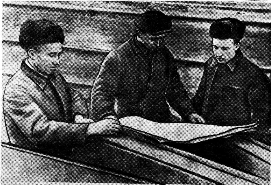
Полным ходом идет ремонт первой домной печи. На снимке (слева направо): разметчик котельно-ремонтного цеха Ш. Ахметжанов, технолог А. Ковалев и разметчик И. Никитин за разметкой лучей подвесной люльки домной печи.
