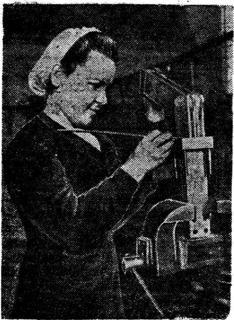
На снимке: одна из лучших электросварщиц электромонтажного цеха З. И. Шорокова, систематически выполняющая нормы выработки на 150—160 процентов при высоком качестве продукции.
