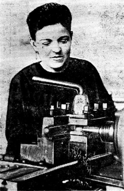
Тонарь-стахановка основного механического цеха Е. Борисенко, применив резцы геометрии В. Колесова, добилась ускорения подачи в три раза, ежедневно выполняет норму на 300 проц.
