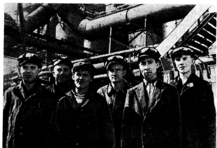
На ремонте первой доменной печи высоких показателей достигла бригада монтажников «Уралдормремонт» Дябилина. Она изо дня в день выполняет норму на 180—200 проц. На снимке: бригада монтажников П. Дябилин, А. Павлов, В. Галайда, Н. Макаров, Ш. Муратшин, П. Свинтунов. Фото Е. Карпова.
