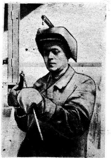
На снимке: передовой электросварщик ТЭЦ С. Р. Ракитский, добившийся высоких показателей на капитальном ремонте парового котла. Фото Е. Карпова.
