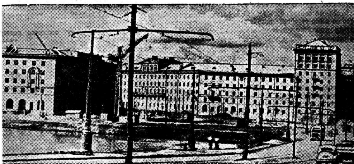
Магнитогорск строится. На снимке: строительство правобережного города.
