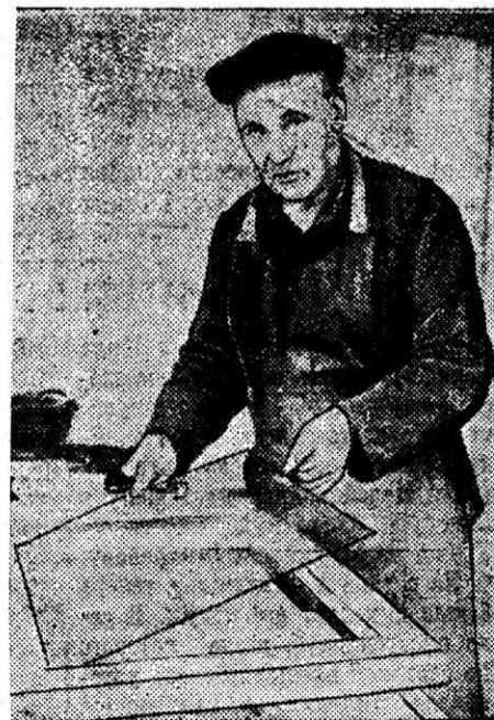
На снимках: первый дом, построенный силами работников ремонтно-строительного цеха. Справа: Н. А. Селиванов за работой.
