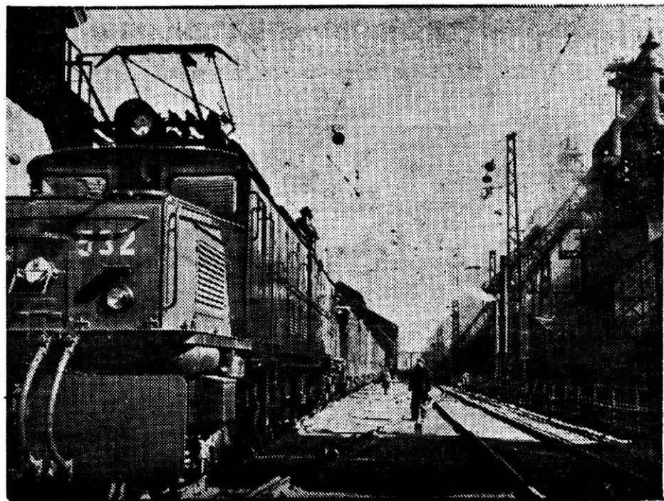
На снимке: разгрузка агломерата на бункерной эстакаде доменного цеха.
